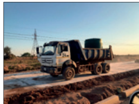
Straßenbau im sambischen Kupfergürtel, Oktober 2018 Quelle: Bildarchiv CCMR
